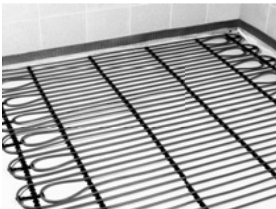
Система напольного отопления/охлаждения («мокрый» способ укладки труб)
