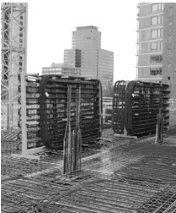
Подогрев и охлаждение ядра бетонных перекрытий
